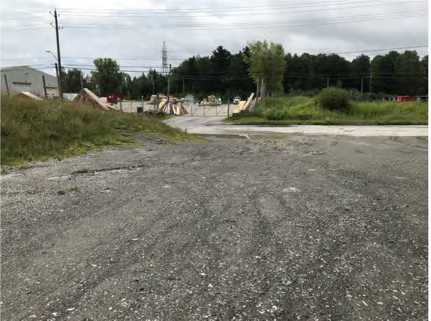
IMG_0830.JPG Image 11: 10h07 - Vue alternative de l'entrée de l'entreprise par la rue Pépin.
