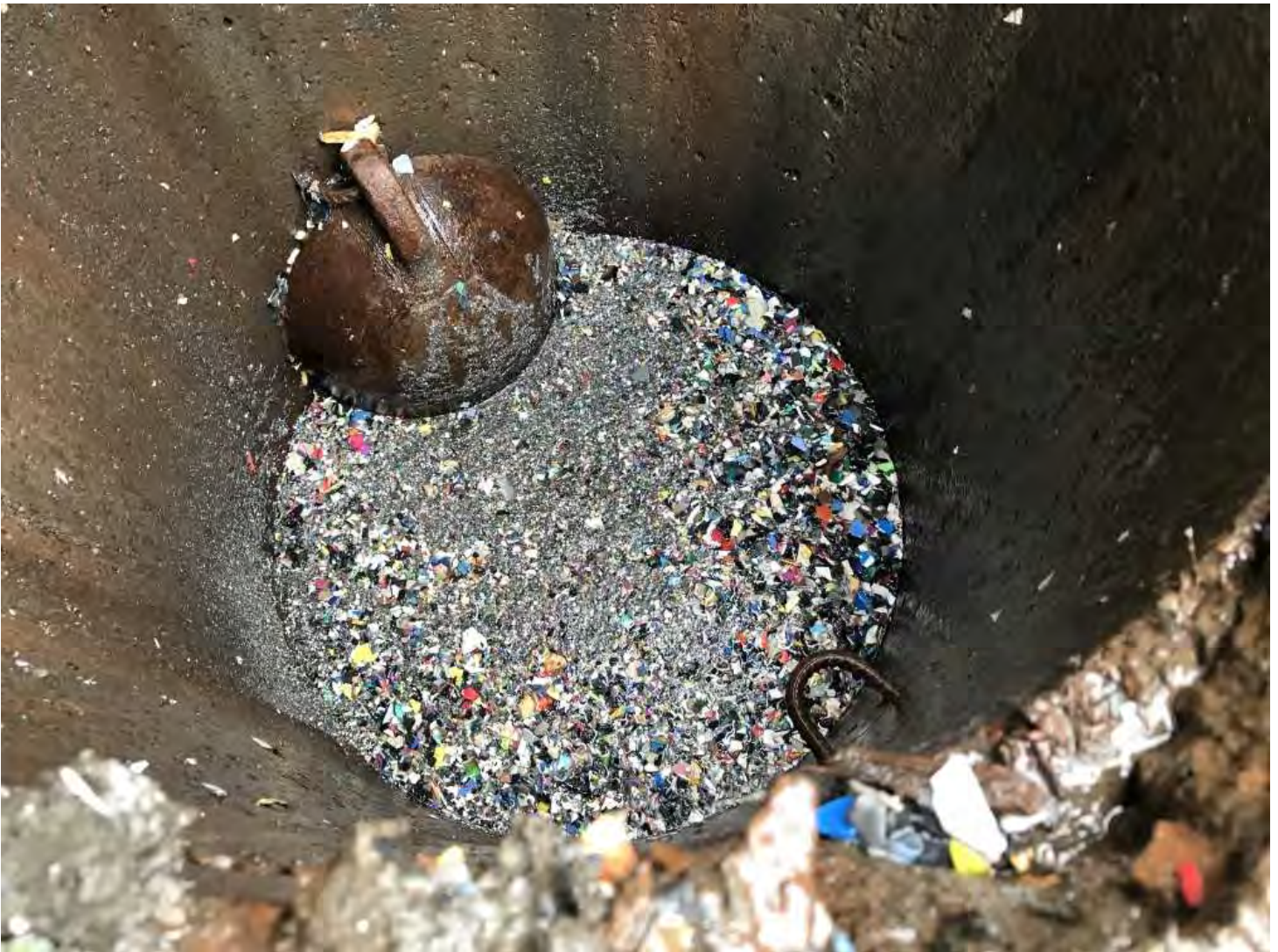
IMG_0831.JPG Image 12: 10h09 - Vue de l'intérieur du puisard de collecte des eaux pluviales de la plateforme B
