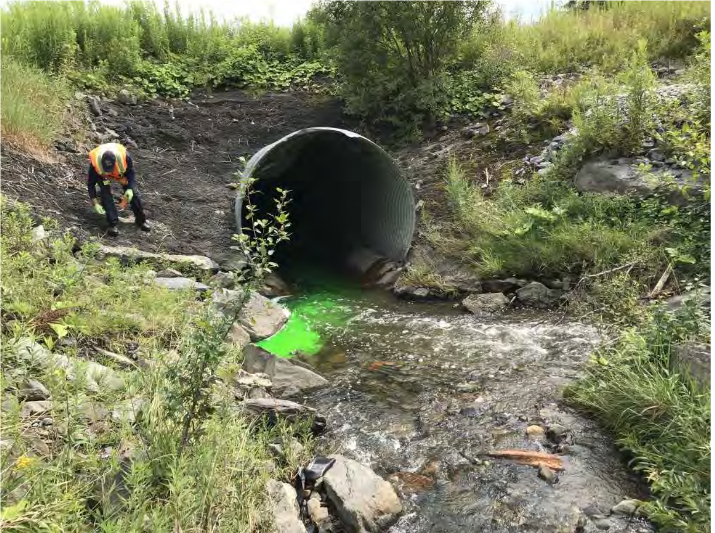
IMG_0923.JPG Image 85: 14h44 - Ajout de fluorescéine avant le ponceau traversant l'autoroute 410. Point GPS 0092
